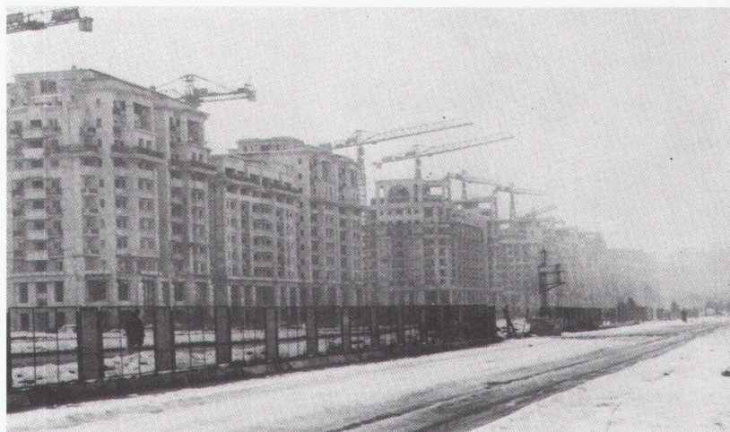
Massenwohnungsbau aus den achtziger Jahren
