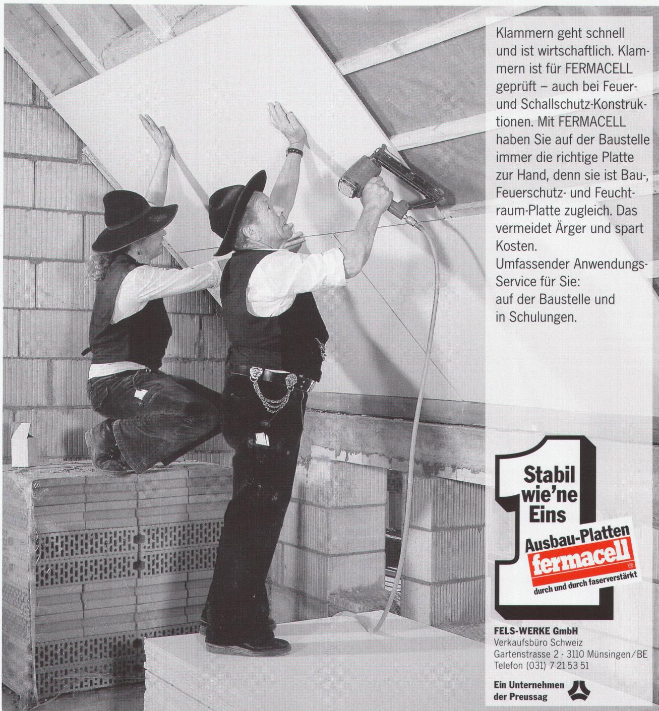
Klammern geht schnell und ist wirtschaftlich. Klammern ist für FERMACELL geprüft – auch bei Feuer- und Schallschutz-Konstruktionen. Mit FERMACELL haben Sie auf der Baustelle immer die richtige Platte zur Hand, denn sie ist Bau-, Feuerschutz- und Feuchtraum-Platte zugleich. Das vermeidet Ärger und spart Kosten.
