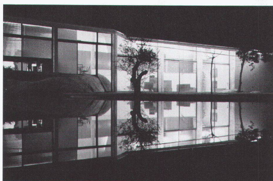
Ansicht Südwest bei Nacht
