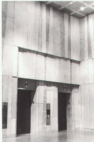
Swiss Bank Tower, New York, Innenverkleidung in Laufener Kalkstein, Böden in Cresciano-Granit.
