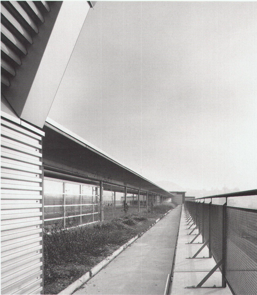
⊗ Dachterrasse / Toiture-terrasse / Roof terrace
