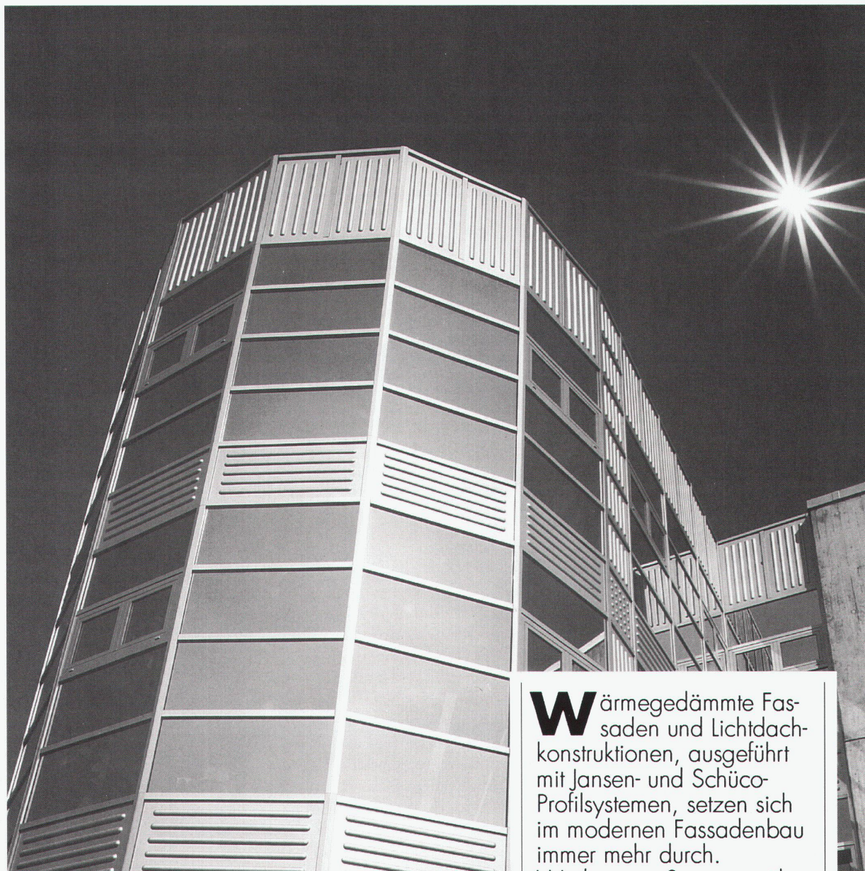
Büro-, Informatik- und Lagergebäude Walterswiler Sport- und Freizeit-Immobilien AG, Baar-Walterswil
