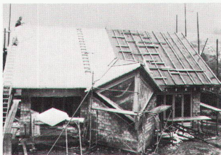
Dachaufbau Haustrennwand 1 Haustrennwand / 2, 3 Saglan-Glaswolle-Isolation / 4 Sparren / 5 Abschlussleiste / 6 Dachschalung; unterbrochen zwischen den beiden Häusern / 7 blaue Sager-Sperrfolie / 8 Hartspanplatte, ca. 20 mm, zur Verbesserung der Schalldämmung, unterbrochen im Bereich der Haustrennwand / 9 Saglan-Glaswolle-Isolation / 10 Durex-Hartschaumplatte / 11 Sager-Abdeckbahn / 12 Konterlattung / 13 Ziegellattung
