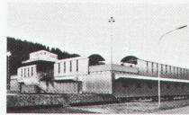
Sportgeschäft Vaucher AG, Bern 06.02 Warenhäuser Heft Nr. 7/8, 1984 Architekten: Atelier 5, Bern
