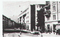
Manessehof, Zürich 01.03. Mehrfamilienhäuser Heft Nr. 10/1984 Architekten: U. Marbach und A. Rüegg, Zürich
