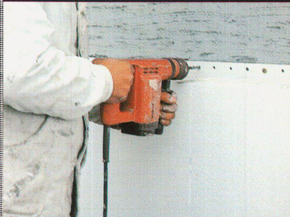
Montage der STO-Halteleisten.
