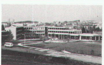
Kantonales Arbeits- und Hauswirtschaftsseminar, Gossau SG 02.04 Mittelschulen Heft Nr. 6/1983 Architekt: O. Baumann, St. Gallen
