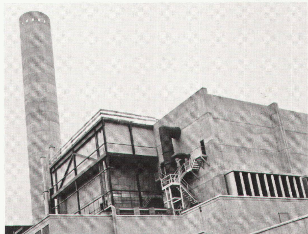
- Kehrlichtverbrennungsanlage Zürich. Wandisolationen.
