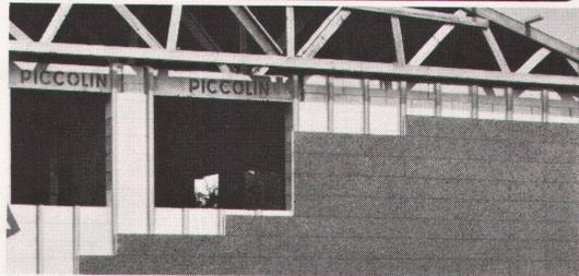
Hochwertiger Glasfaserbeton in der Fassadenausführung «standard» oder «nach Mass». Die hinterlüftete CEMFOR-Fassade setzt neue Masstäbe: Ausserordentlich widerstandsfähig gegen Beschädigung und alle Witterungseinflüsse • Formstabil • Nicht brennbar • Durchgefärbt oder versiegelte Acryldispersionsbeschichtung • Wartungsfrei • Natürliche Alterung durch raffiniert geformte Oberfläche • Oberflächengestaltung nach Wunsch • Einfache Montage • Gute Bearbeitbarkeit • Preisgünstig.
