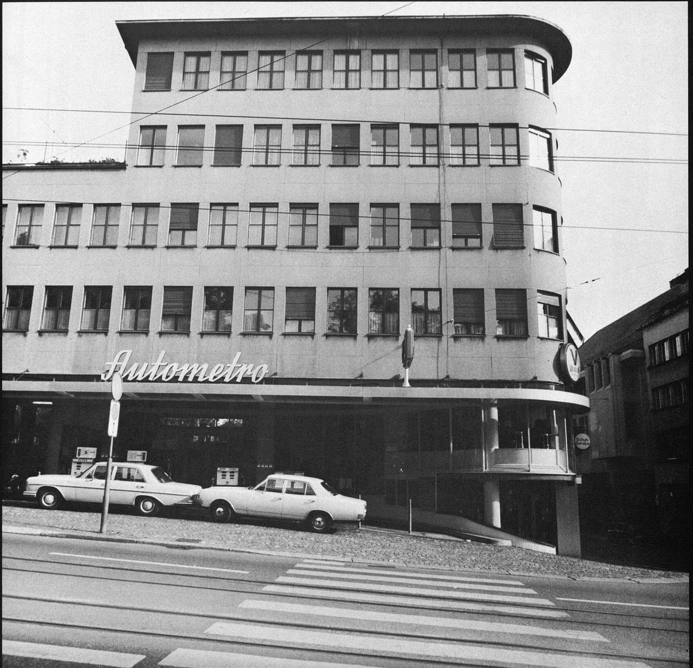
58 K. Knell, Architekt/architecte, Eckhaus Rämistrasse/Stadelhoferstrasse (1935).
