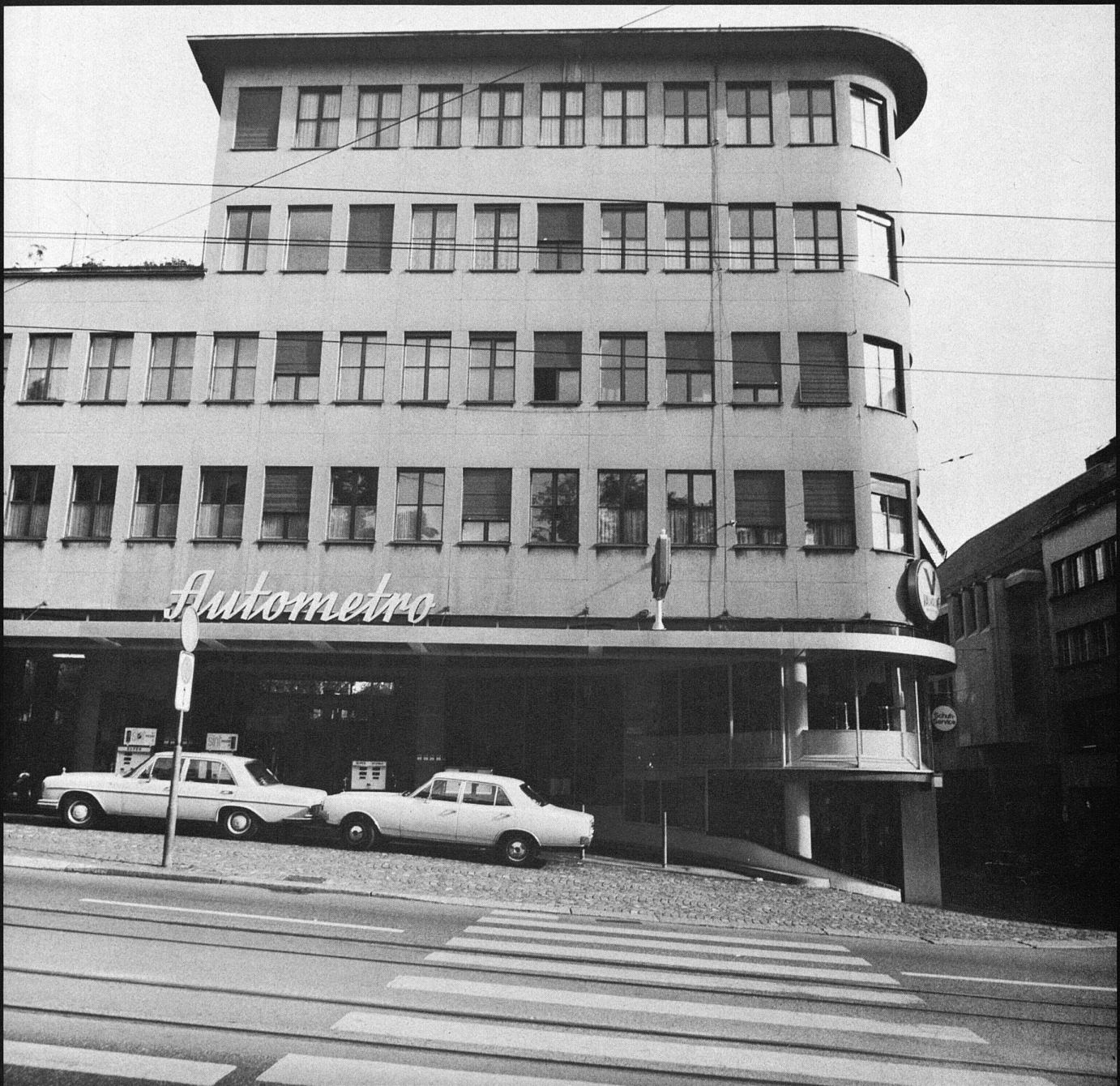
58 K. Knell, Architekt/architecte, Eckhaus Rämistrasse/Stadelhoferstrasse (1935).
