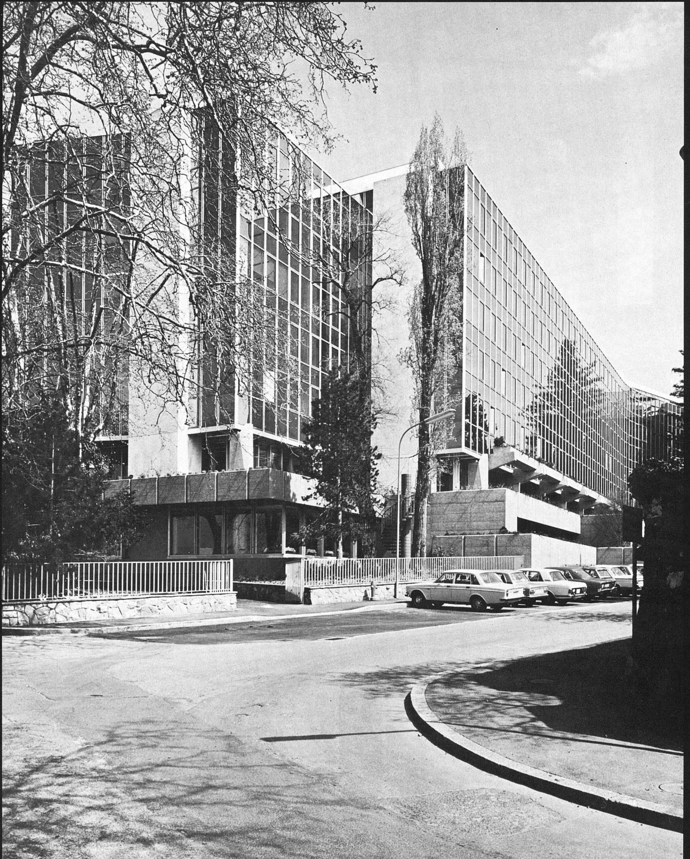
Südöstliche Fassadenpartie, von der Seestrasse her gesehen
