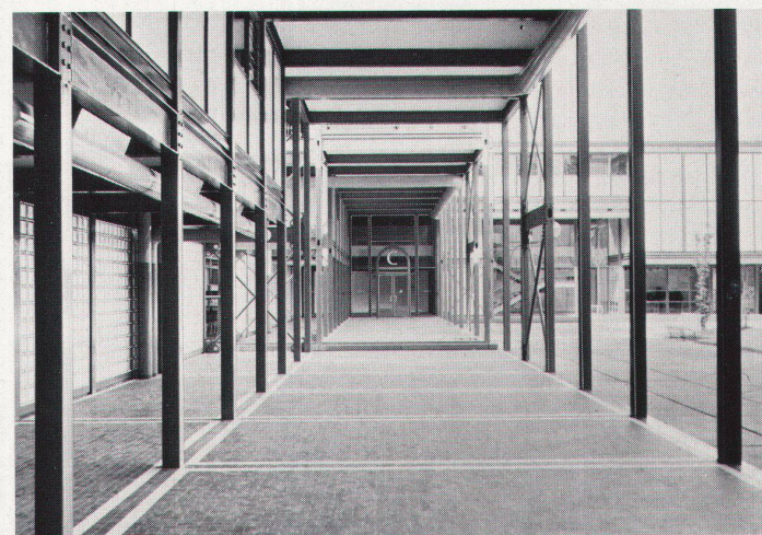
Le portique qui relie les bâtiments B et C
