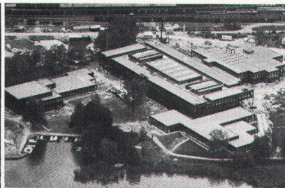
Technikum Rapperswil – ein klarer Fall – Holorib für Stahlkonstruktionen.
