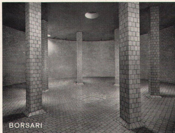
Flughafen-Immobilien-Gesellschaft Zürich-Kloten 7 Tanks total 5600 m 3 Schweröl
