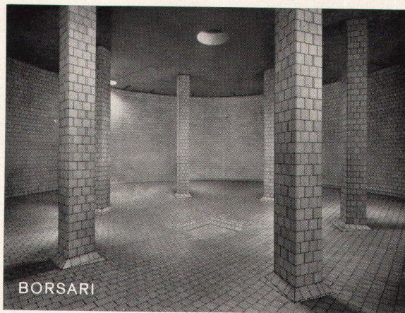
Flughafen-Immobilien-Gesellschaft Zürich-Kloten 7 Tanks total 5600 m 3 Schweröl
