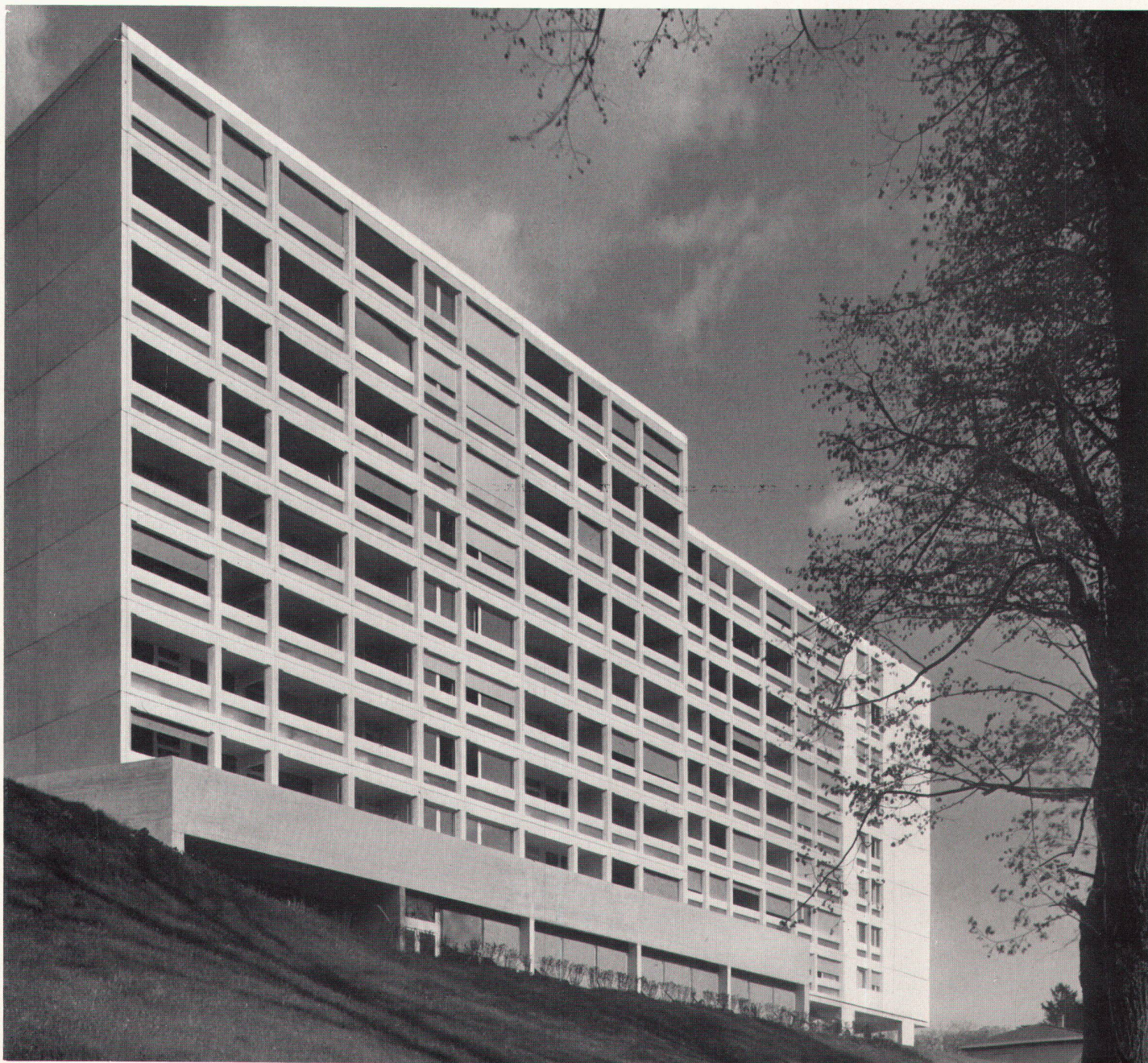
En Champ Mogins, Nyon. Architekt: Béric S. A., Genf, Ingenieur: Beric S. A., Genf
