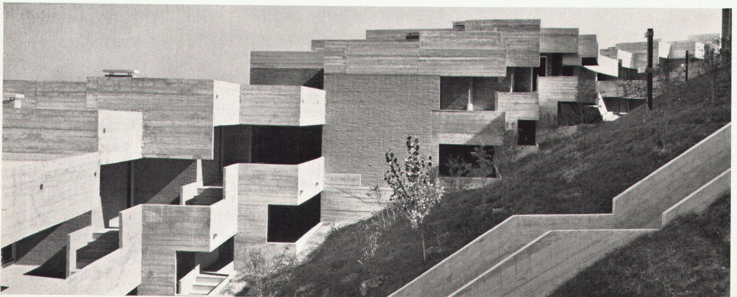
13 Blick von den äußeren Studentenzimmern auf die inneren Chambres des étudiants intérieures vues depuis les chambres exté- rieures View from outer students' rooms onto inner rooms
