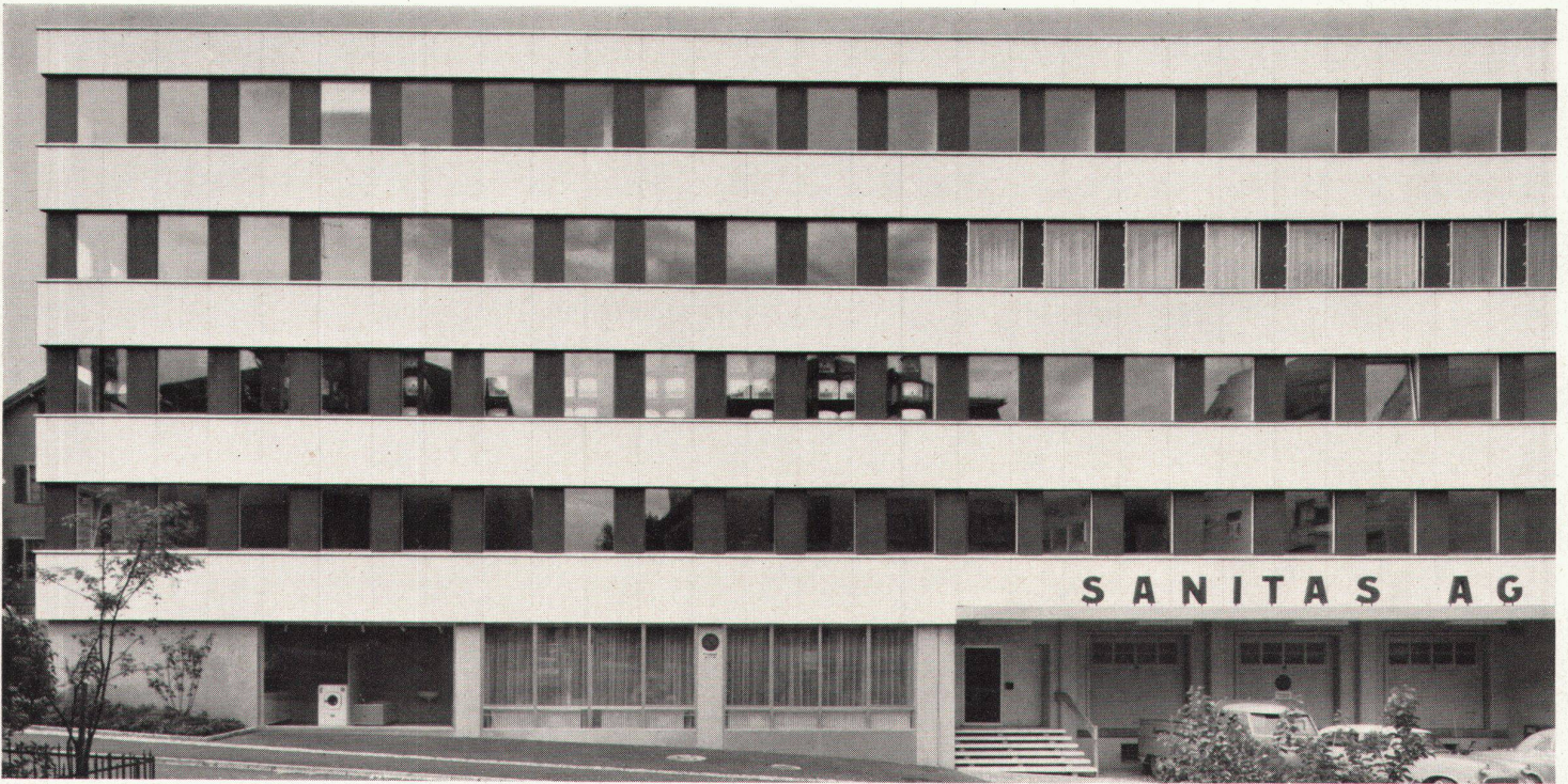
Eternitfassaden System Keller
