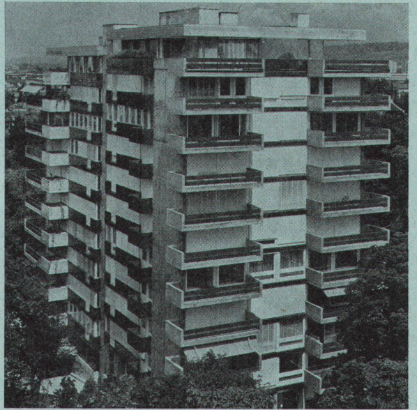
Wohnhaus St. Alban-Anlage 25, Basel. Architektengemeinschaft: Werner Gantenbein BSA/SIA, Zürich, und Christoph E. Hoffmann SIA, Basel
