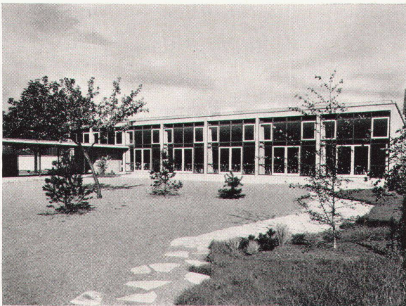
Großzügige Verglasungen ermöglichen dem Kantinenbesucher den Blick ins Freie
