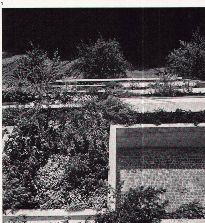
1 Nordwestecke mit Ateliaraufbau Partie sud-ouest et superstructure des studios Northwest corner with studio superstructure
