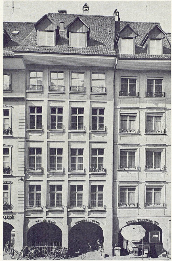
3 Fassaden an der Spitalgasse nach der Renovation und Aufstockung La façade donnant sur la «Spitalgasse» après la rénovation et le rehaussement The Spitalgasse elevations after restoration and superimposition of new floors
