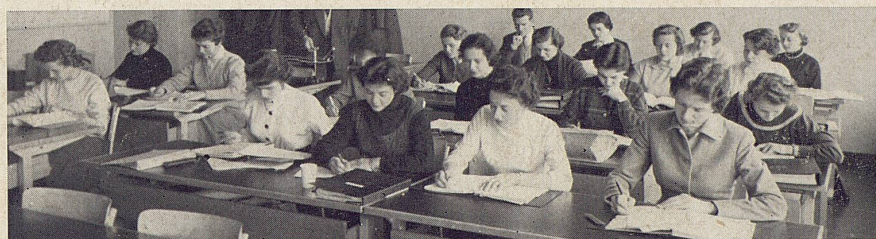
Bild oben: Bannfeld-Schulhaus Olten, Juli 1957 eingeweiht, Architekt Hermann Frey BSA/SIA, Olten Bild Mitte: Kantonsschule Zürcher Oberland, Wetzikon, eingeweiht Juni 1957, Architekt Max Ziegler SIA, Zürich Bild unten: Hostessenklasse im Ausbildungszentrum der Swissair, Kloten
