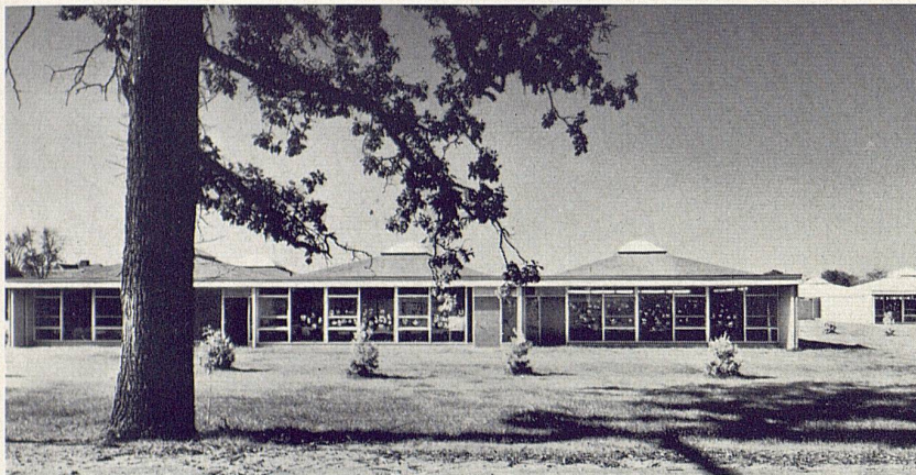
6 Klassenraum mit zentralem Oberlicht Une salle d'école avec jour à plomb central Classroom with skylight in the centre of the ceiling
