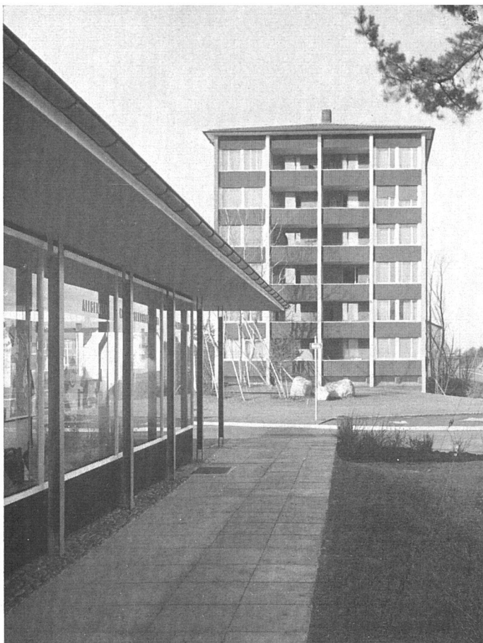
Lebensmittelladen mit Blick auf Turmhaus (Arch. C.+J.+P.) | Le magasin et l'immeuble locatif | The food shop and the block of flats
