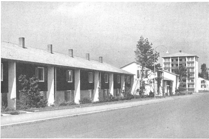
Die Zufahrtsstraße (Opfikonstraße) | Voie d'accès | Access road
