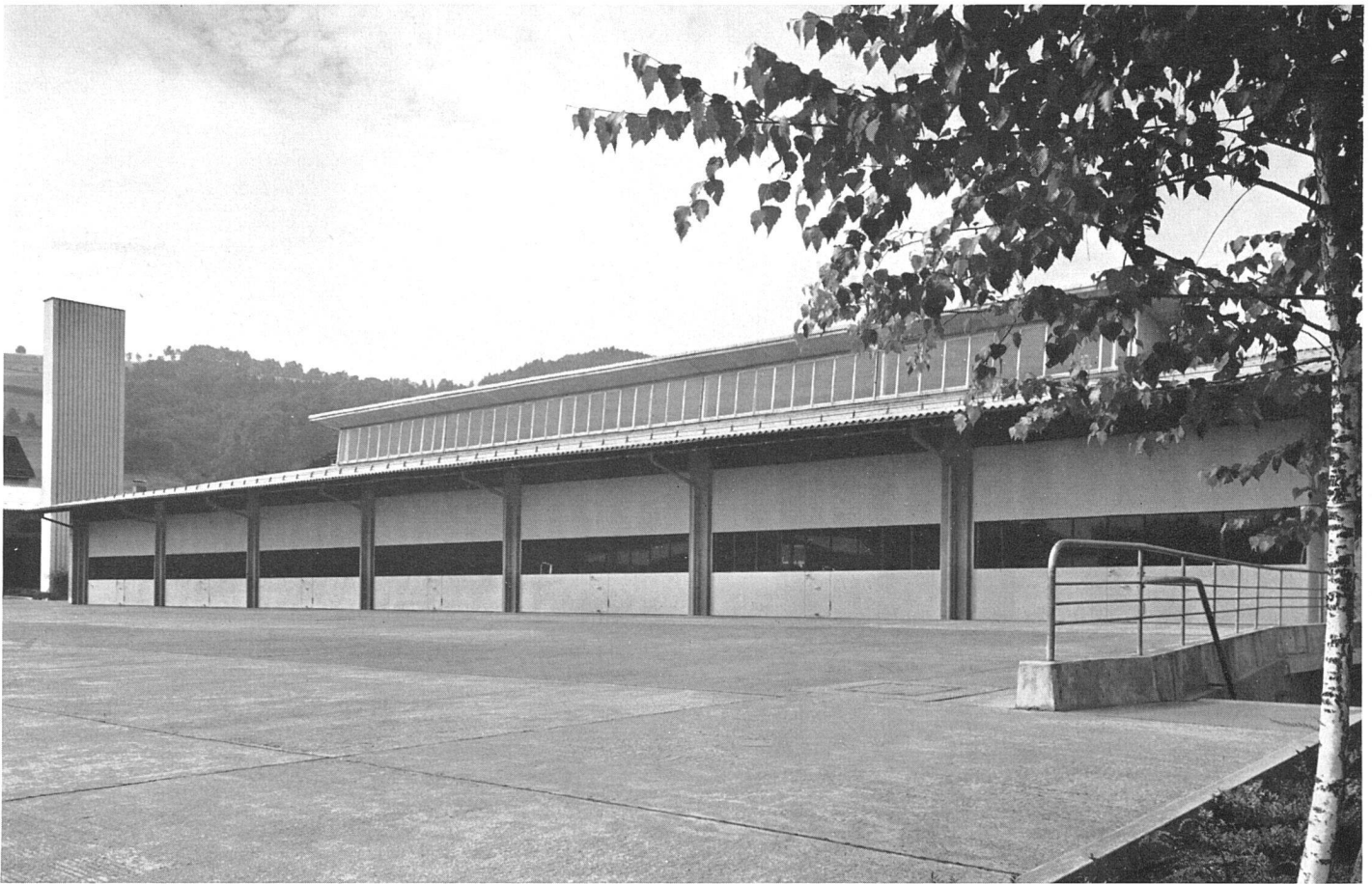
Postgarage und Einstellhalle von Norden | Garage d'autobus; vue prise du nord | Bus garage from the north
