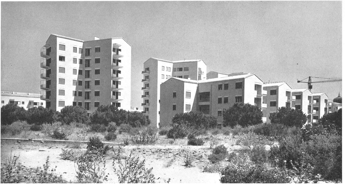
Ansicht des Wohnquartiers von Südwesten, rechts viergeschossige Mietbauten / Vue générale prise du sud-ouest / General view from the south-west Photos: A. Cartoni, Rom
