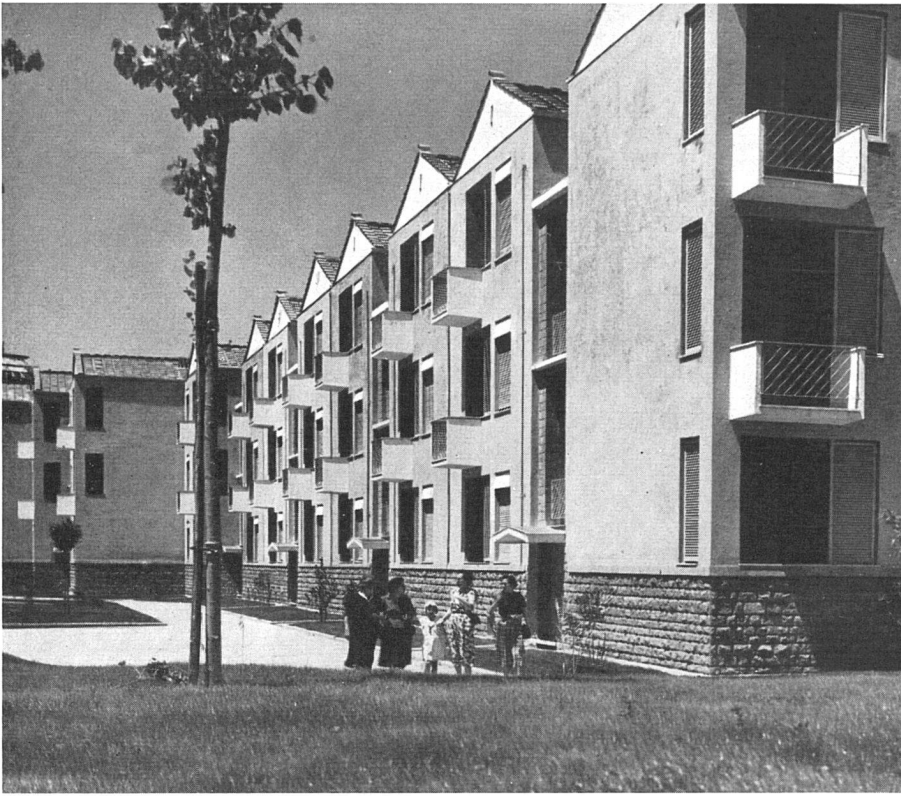
Fassadenausschnitt der dreigeschossigen Miethäuser / Détail de façade / Elevation detail
