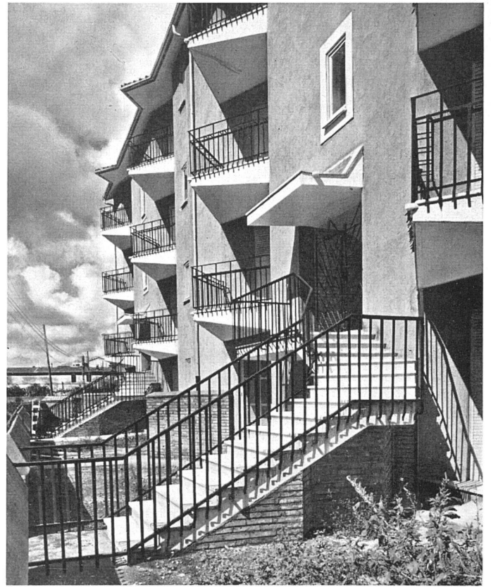
Fassadenausschnitt mit Balkonen, Wohnbau von Architekt Mario Ridolfi | Détail de façade | Elevation detail
