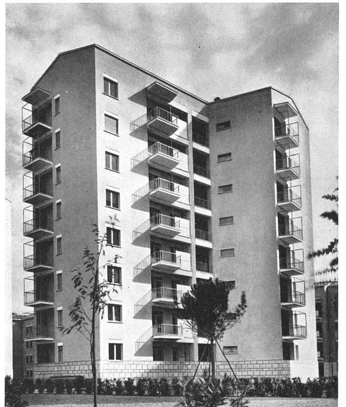
Ein Turmhaus. Architekten G. Pediconi und M. Paniconi / Un immeuble-tour / A point-house
