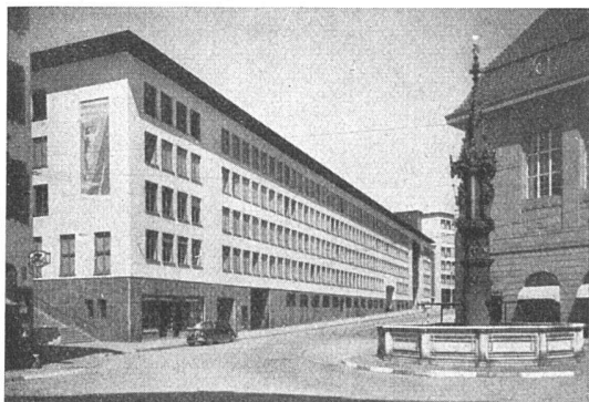
Polizei-Verwaltungsgebäude Spiegelhof Basel Von der Mühl & Oberrauch, Architekten, Basel
