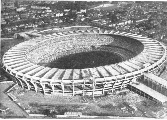
Stadion der Stadt Rio de Janeiro für 150 000 Besucher. Zugänge durch Rampen in der Querachse angeordnet. Architekten: R. Galvao, P.P. Bastos, A. Dias Carneiro & A. Azevedo | Stade municipal de Rio | Municipal stadium of Rio
