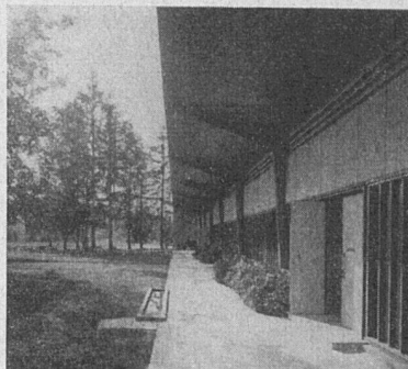
Vestiaires du stade de Champel G. Brera et P. Waltenspühl, architectes FAS
