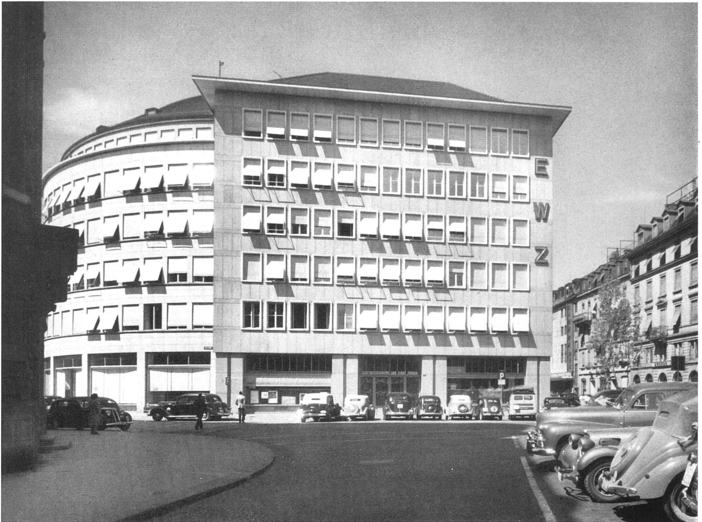
Ansicht vom Werdmühleplatz | Vue prise de la Werdmühleplatz | View from Werdmühleplatz
