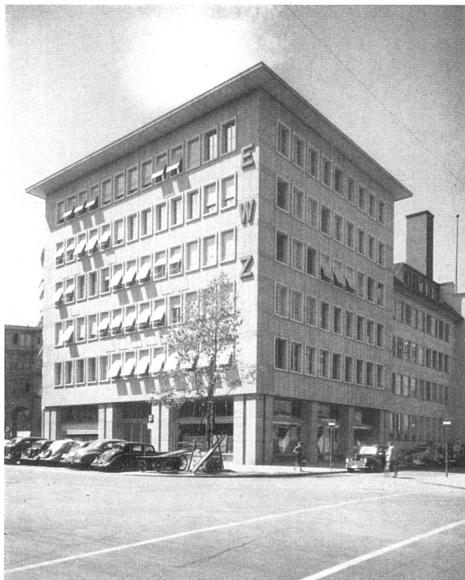
Ansicht von Nordosten | Vue prise du nord-est | View from north east
