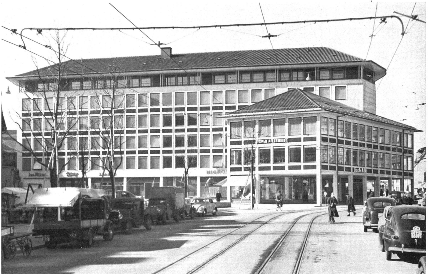
Ansicht vom Marktplatz. Brüstungsplatten des Hauptbaues in schwarzer, die des Anbaues in roter Keramik | Vue prise de la place du Marché | View from Market Place Photo: Hans Diem, St. Gallen
