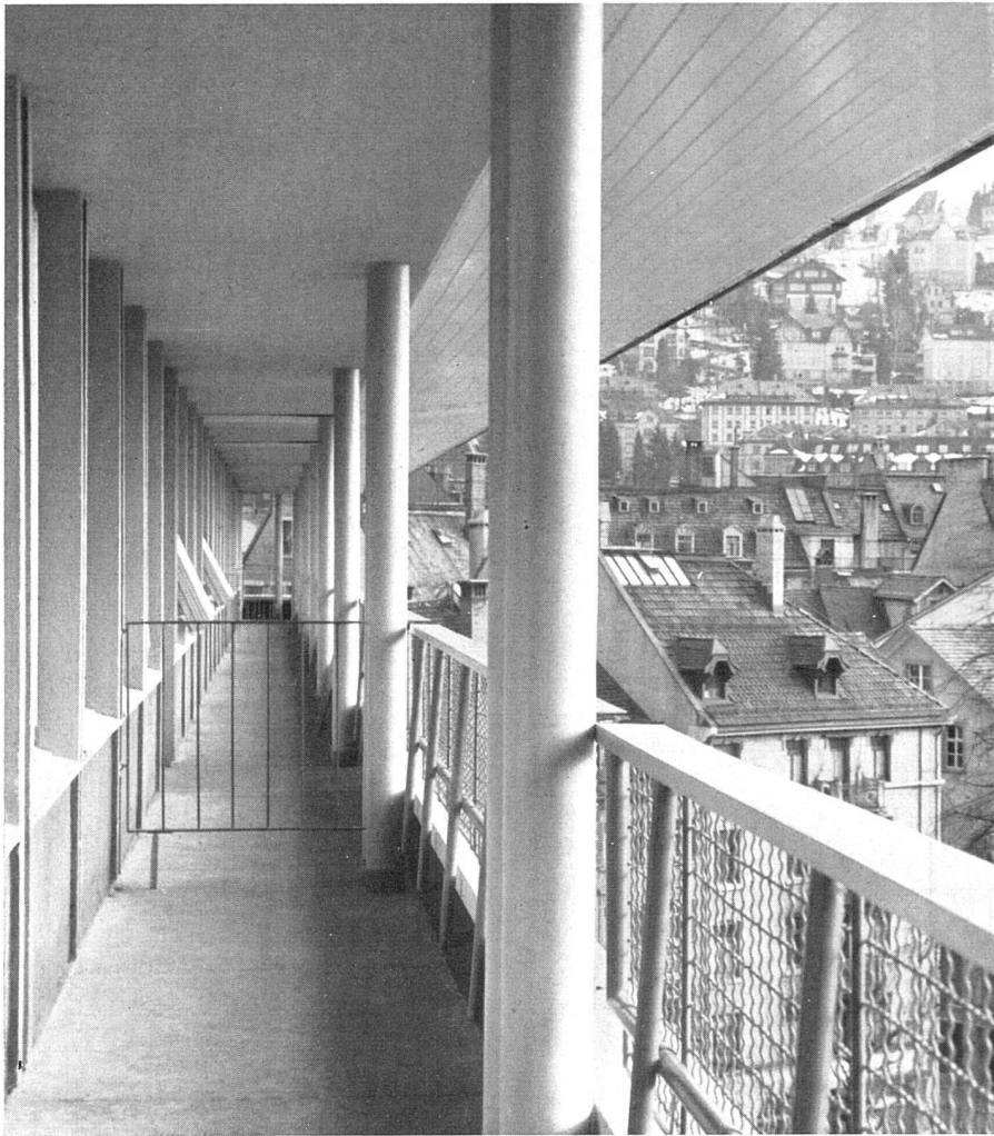
Galerie des Dachgeschosses | Galerie de l'étage supérieur | Gallery of garret storey
