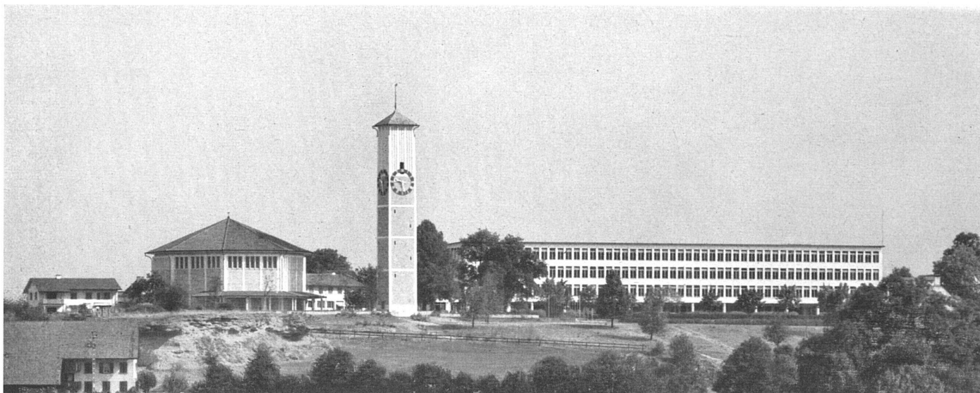
Gesamtansicht von Süden, rechts das 1933 erbaute Schulhaus | Vue d'ensemble prise du sud, à dr. l'école réalisée en 1933 | General view from south, at r. the school built in 1933 Photo: H. Wolf-Benders Erben, Zürich
