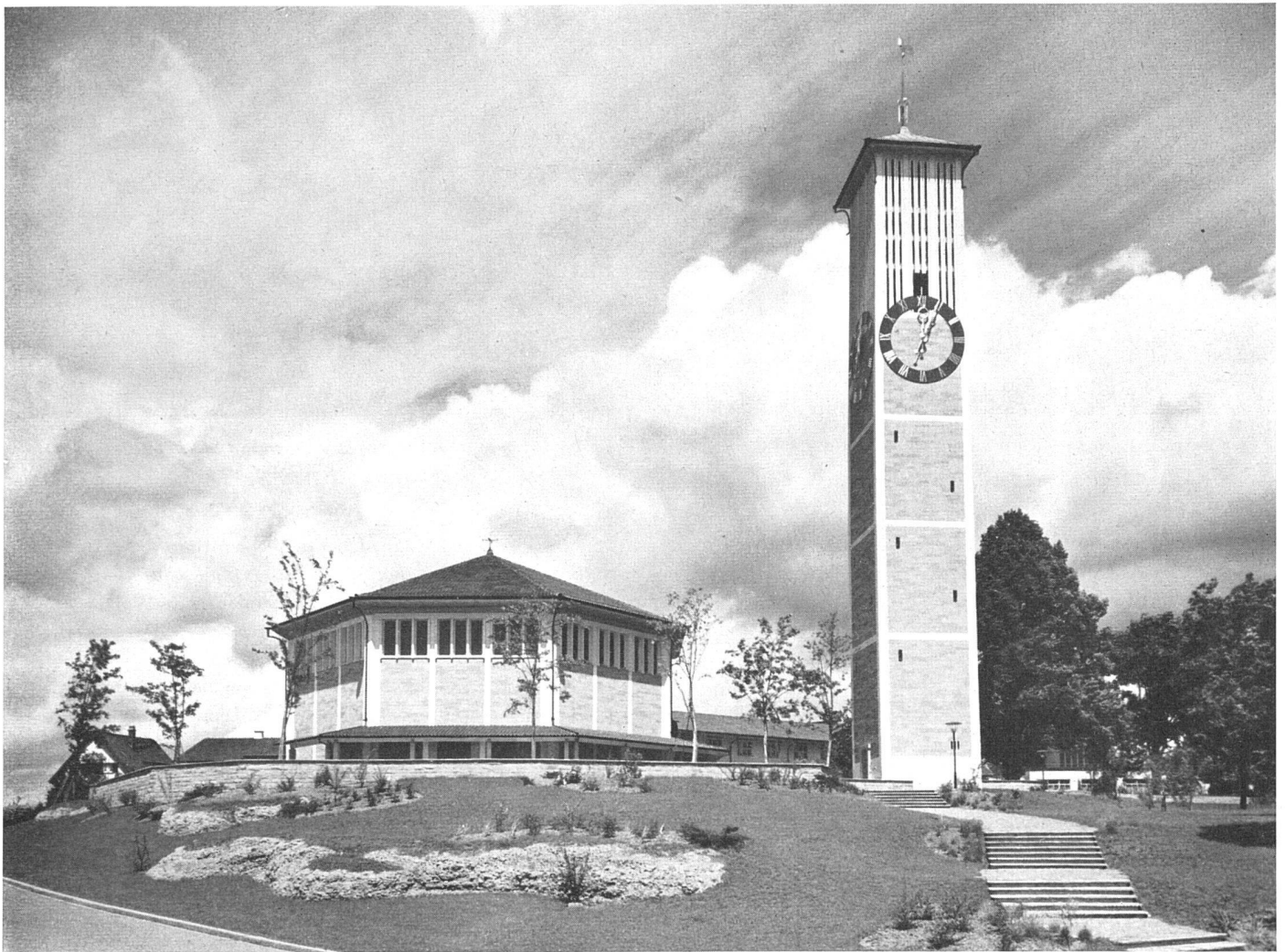
Ansicht der Kirche von Süden | Vue d'ensemble prise du sud | General view from south
