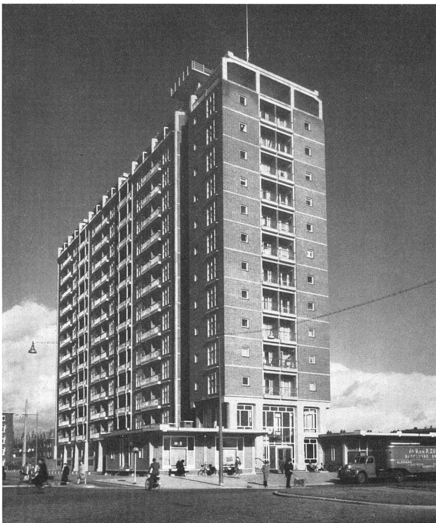
Südwest-Ansicht mit Hauptfront | Vue prise du sud-ouest | View from south-east
