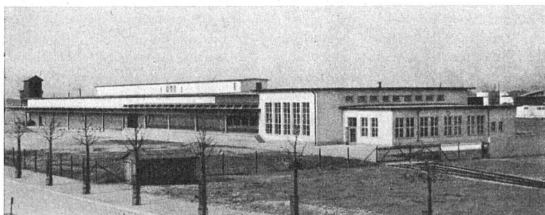
Kühlhaus des Schlachthofs Basel. Architekt: Willi Kehlstadt BSA
