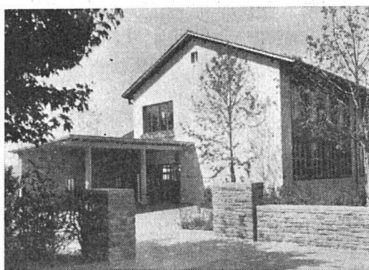
Erweiterungsbauten Schulhaus Triemli, Zürich. Photo: Bachmann, Zürich
