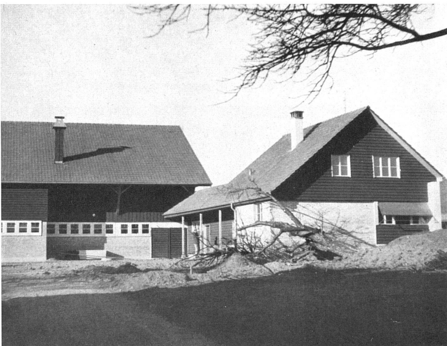
Wohnhaus und Scheune von Süden | L'habitation et la ferme vues du sud | The residence and the farm from south
