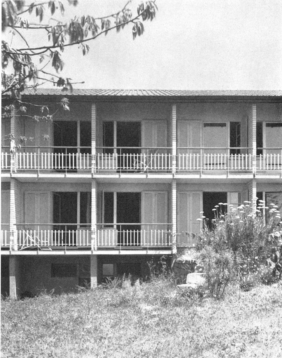
Ausschnitt Südfassade Hauptgebäude | Partie de la façade sud du bâtiment principal | South elevation of the main building Photo: H. Finsler SWB, Zürich
