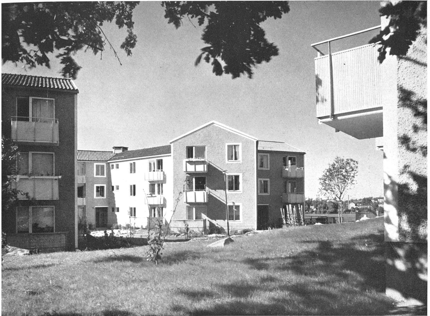
Blick von Osten in einen Hof, rechts freistehendes Sternhaus / Vue générale prise de l'est; à gauche une maison en étoile détachée / General view from east, detached star house at left
