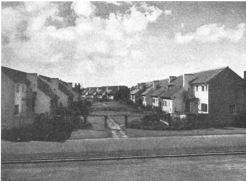
Gartenstadt «Friluftstaden» in Malmö (Schweden). Architekt: Eric S. Persson. Die einzelnen Einfamilienhäuser (für 1-2 und 4-6 Personen) sind gegeneinander versetzt; ihre Eingänge liegen abwechselnd auf der Vorder- und Rückseite. Aus «The Architects' Journal» (London), 31. Oktober 1946
