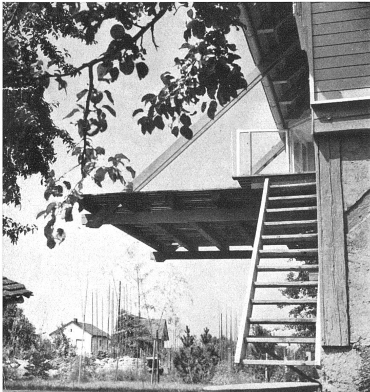
Treppenaufgang mit aufgehängtem Balkon / Escalier et balcon suspendu / Staircase and suspended balcony
