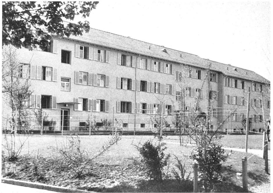
Wohnbauten in Zürich, ausgeführt im System Schindler/Göhner 1947. Bauzeit 3 Monate. Kosten 10-15% billiger als bei normaler Bauweise | Ce système permet la construction à étages multiples de habitations bon marché à Zurich | A system for multistory houses, block of flats in Zurich
