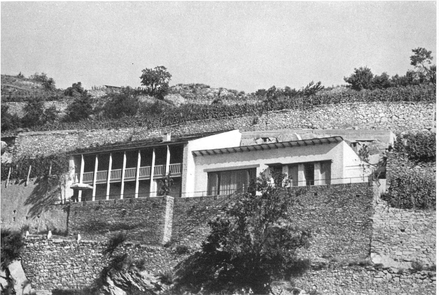
Gesamtansicht von Südost, links Schlaftrakt, rechts Wohntrakt / Vue d'ensemble prise du sud-est; à gauche la partie nuit, à droite la partie jour / General view from the south-east, left the bed-room wing, right the living-quarters
