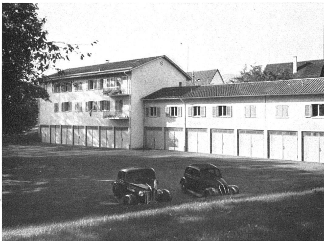
Dienstgebäude mit Parkplatz / Bâtiment de service et stationnement pour voitures / Service building and parking space
