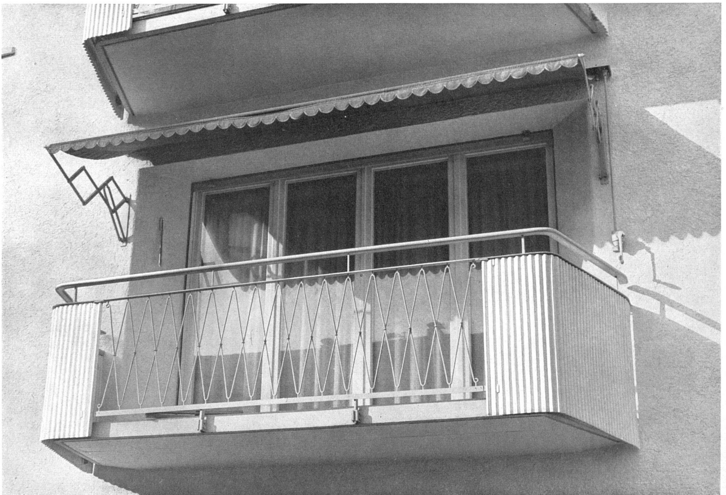
Wohnungsbalkon aus Eisen und Welleternit / Balcon en fer et «Eternit» ondulé / Balcony of steel and corrugated asbestos-cement
