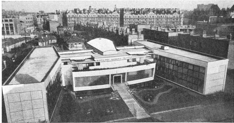
13/14 Pioneer Health Centre, Peckham, London 1935. Eisenbetonbau, enthält Turnhalle, Schwimmbad, Leseräume, medizin. Konsultationsräume. Architekt Sir Owen Williams, K.B.E.
