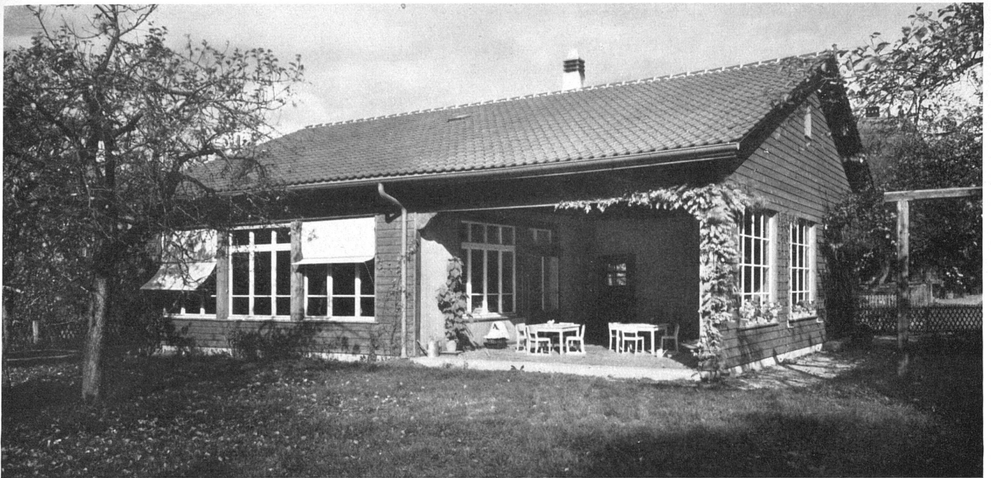
Abb. 35 Gesamtansicht von Südosten / Vue générale du sud-est / General view from the south-east
