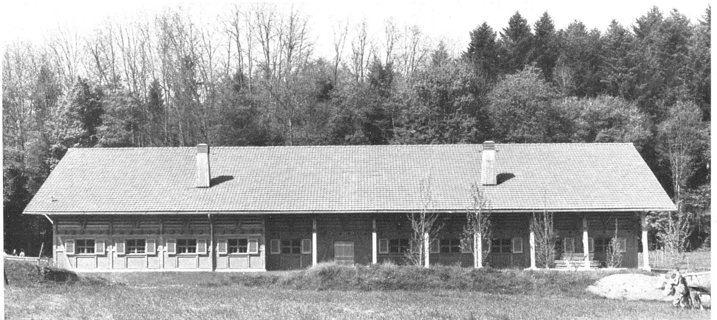
Gesamtansicht von Süden
